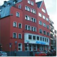
Hotel Lyskirchen - Altstadthotel mit Tradition Filzengraben 26-32 50676 Köln
